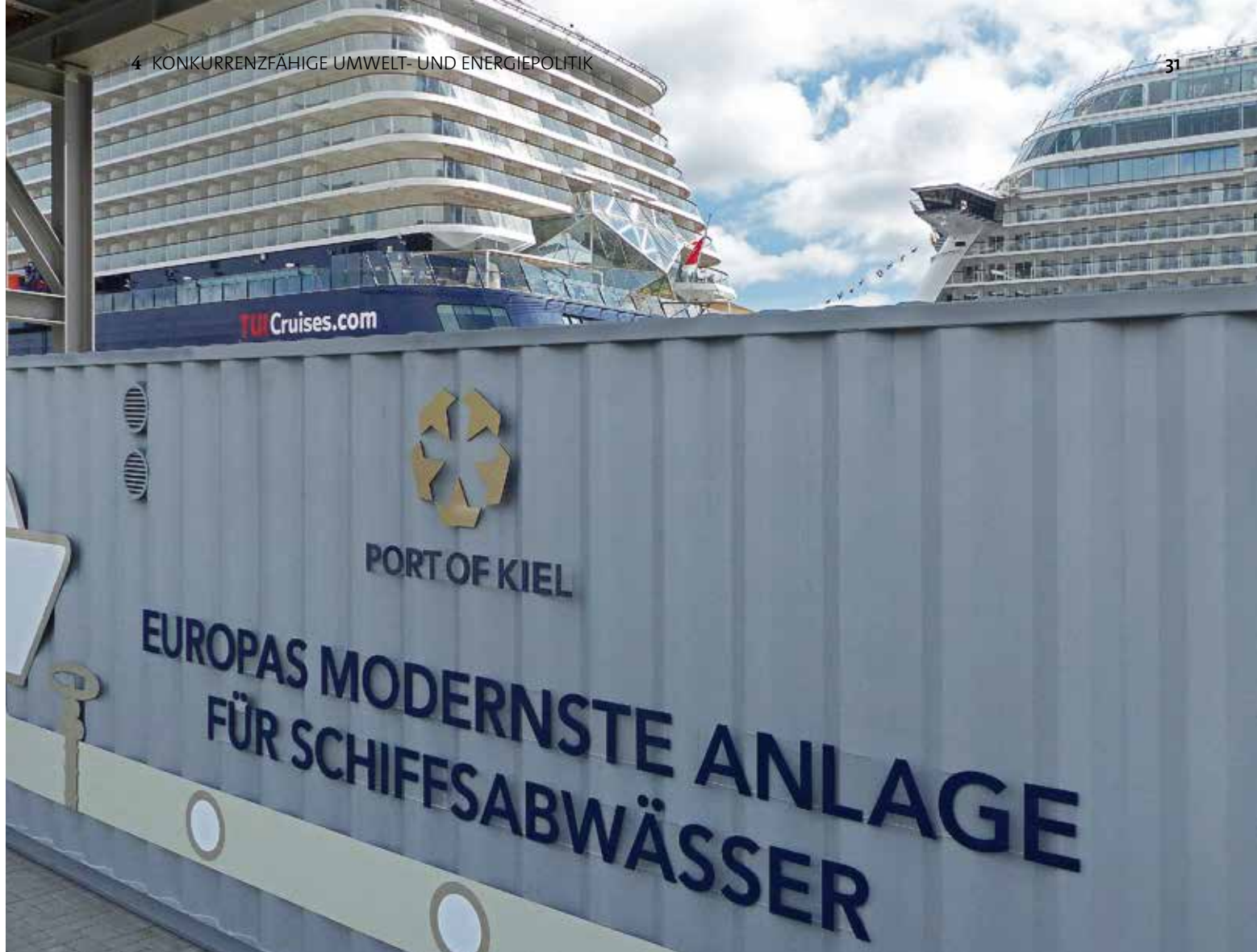
Hafenauffanganlage in Kiel
